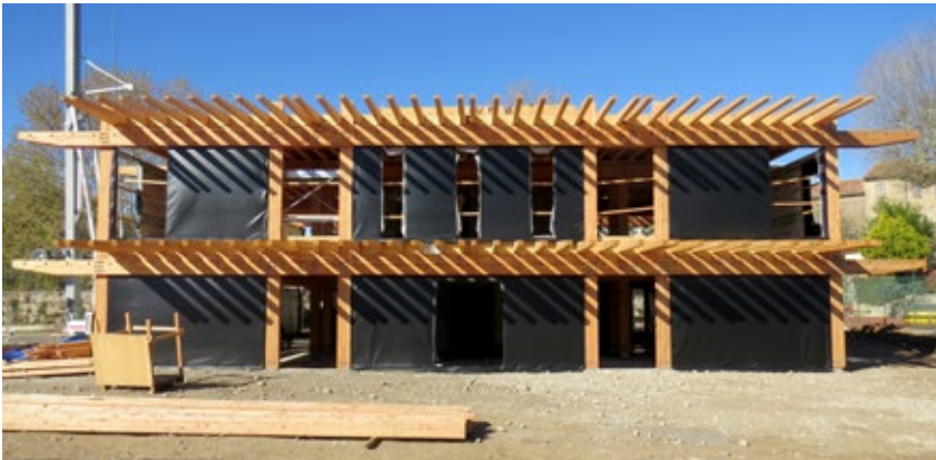
Chantier de la future maison de santé d'Aups (Var).
