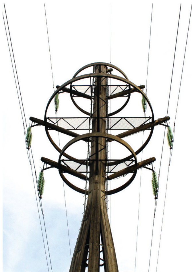
Pylône électrique haute tension, Martin Szekely, 1994
